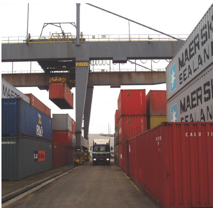
Figuur 1.10 Containerterminal Nijmegen
