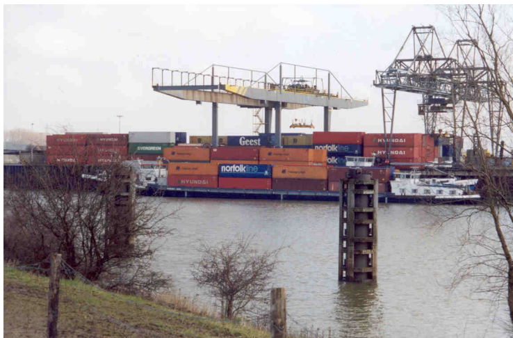
Figuur 1.9 Containerterminal Nijmegen
