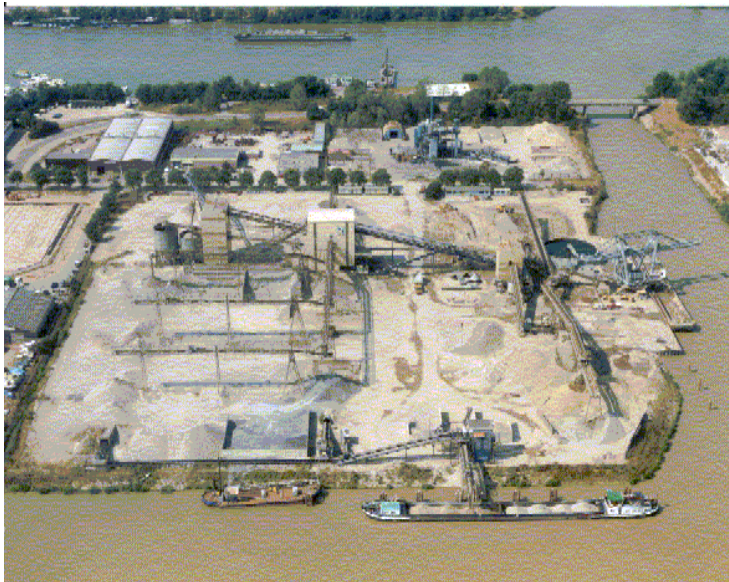
Figuur 1.9 Grindverwerkingsinstallatie Smals Cuijk (Bron: Website www.smals.com )
