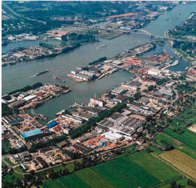
Figuur 1.6 Bedrijventerrein Oosteind / Ketelhaven Papendrecht Bron: Provincie Zuid-Holland, Duurzaam Economisch Ruimtegebruik (Decor)
