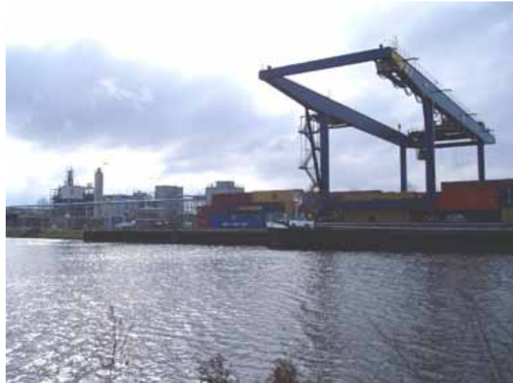
Figuur 3.5 Combiterminal Twente met op de achtergrond Akzo Nobel in Hengelo gelegen aan het Twentekanaal
