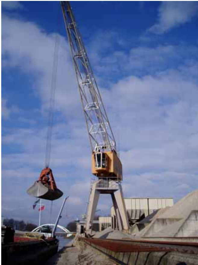
Figuur 4.4 Zand en grindoverslag aan Twentekanaal in Hengelo
